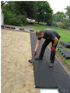
Die Platten der ersten und letzten Reihe sowie alle Rand- bzw. Eckprofile können untereinander sowie mit der Flächenbegrenzung bzw. Kanteneinfassung verklebt werden, um die Platten gegen unbefugtes Entfernen zu sichern.
